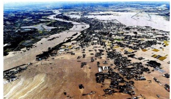
鬼怒川の堤防（左下）が決壊し、濁水した市街地。後方が上流（10日午後4時24分、茨城県常総市で、本社へりから）一林陶一撮影
