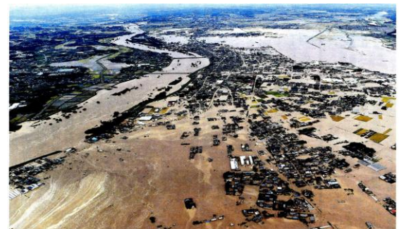
鬼怒川の堤防（左下）が決壊し、濁水した市街地。後方が上流（10日午後4時24分、茨城県常総市で、本社ヘリから）一林陽一撮影
